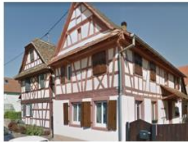
Maisons avec façades à colombages rue du Général de Gaulle, l'une avec demi-croupe
