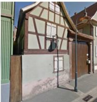
Schlupf et porche rue du Général de Gaulle
