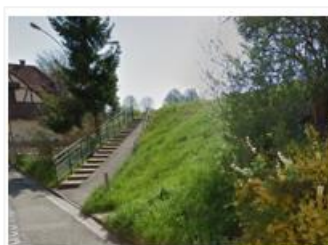
Vue depuis la rue des Acacias (accès en emplacement réservé)
