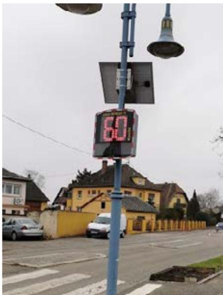
Ce dernier radar permettra de recueillir de nombreuses statistiques : vitesse maximale, moyenne ainsi que le nombre de passage de véhicules par jour. L'objectif de ces dispositifs est de sensibiliser les conducteurs sur la nécessité de respecter les limitations mais également d'identifier les horaires critiques durant lesquels les véhicules circulent à une vitesse excessive en mettant en danger les autres habitants.
